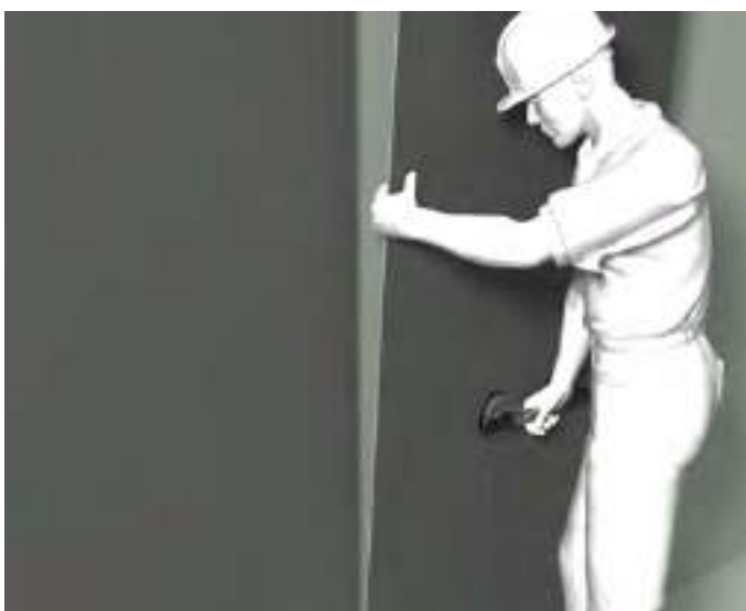
Umístění desky pomocí přísavek
